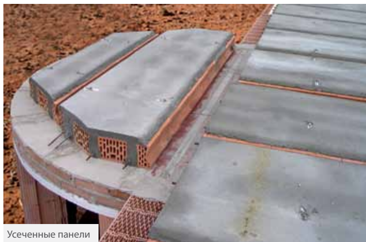
Скорость монтажа панелей – приб. 140 м 2 за 2 часа
