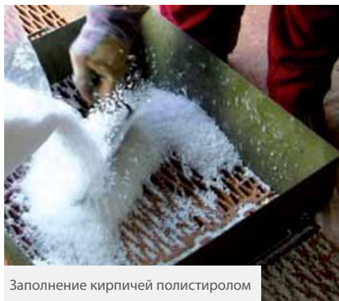
Полистирол в откосах с крайними кирпичами
