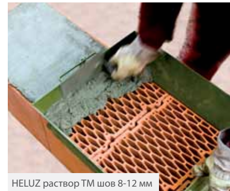
Нанесение раствора для фундамента
