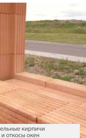
Дополнительные кирпичи – решение углов
